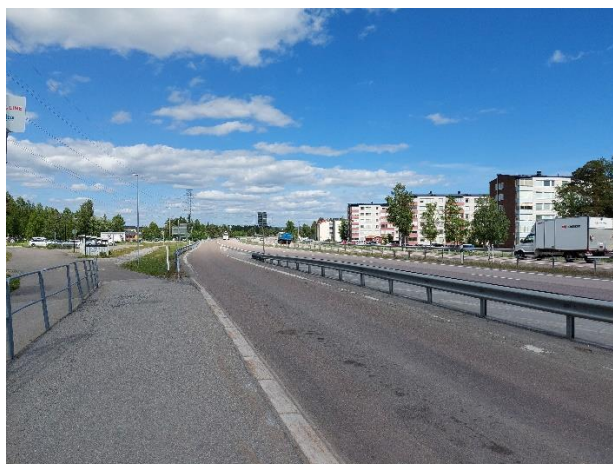
Bild 4. Vy mot norr E4, centrum Timrå.
