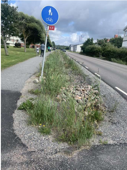
Figur 37 Exempel på dike med flödesdämpande funktion
