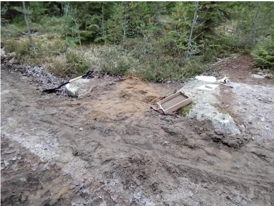
Figur 7. Grävning för hand vid markfast block i intill väg.
