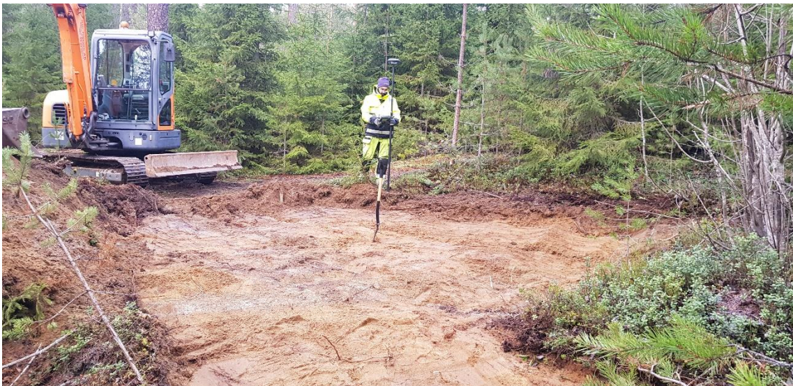
Figur 5. Arbetsbild. Inmätning och grävning vid schakt 2. Foto från sydöst.
