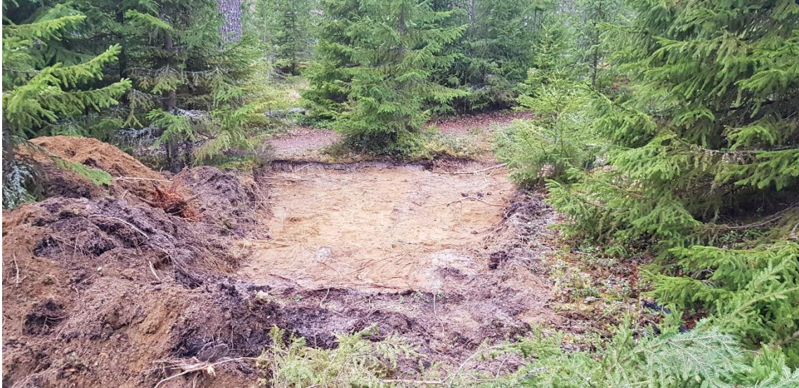
Figur 4. Schakt 1. Foto från öster
