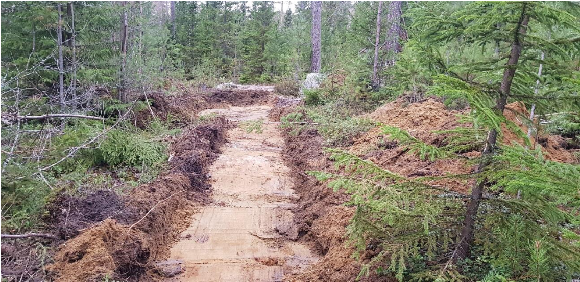
Figur 6. Schakt 3, foto från öster.
