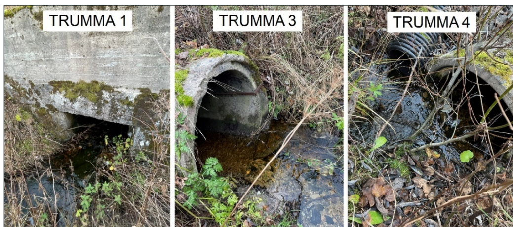
Figur 6. Identifierade trummor vid trumminventering, där trumma 2 inte påträffades.
