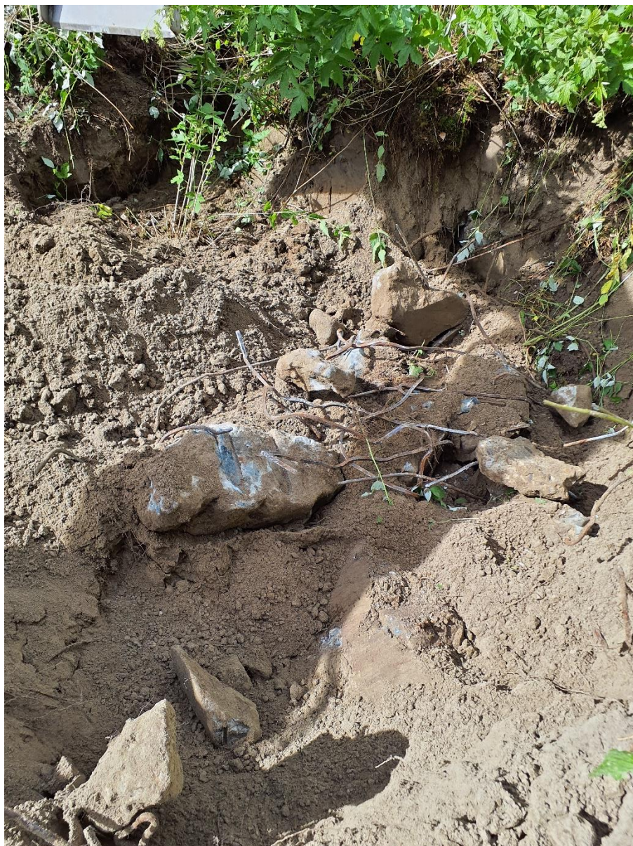
Bild 9. Provpunkt 22W08_hög. Provgrop innehållande bl.a. armeringsjärn och betongfundament.
