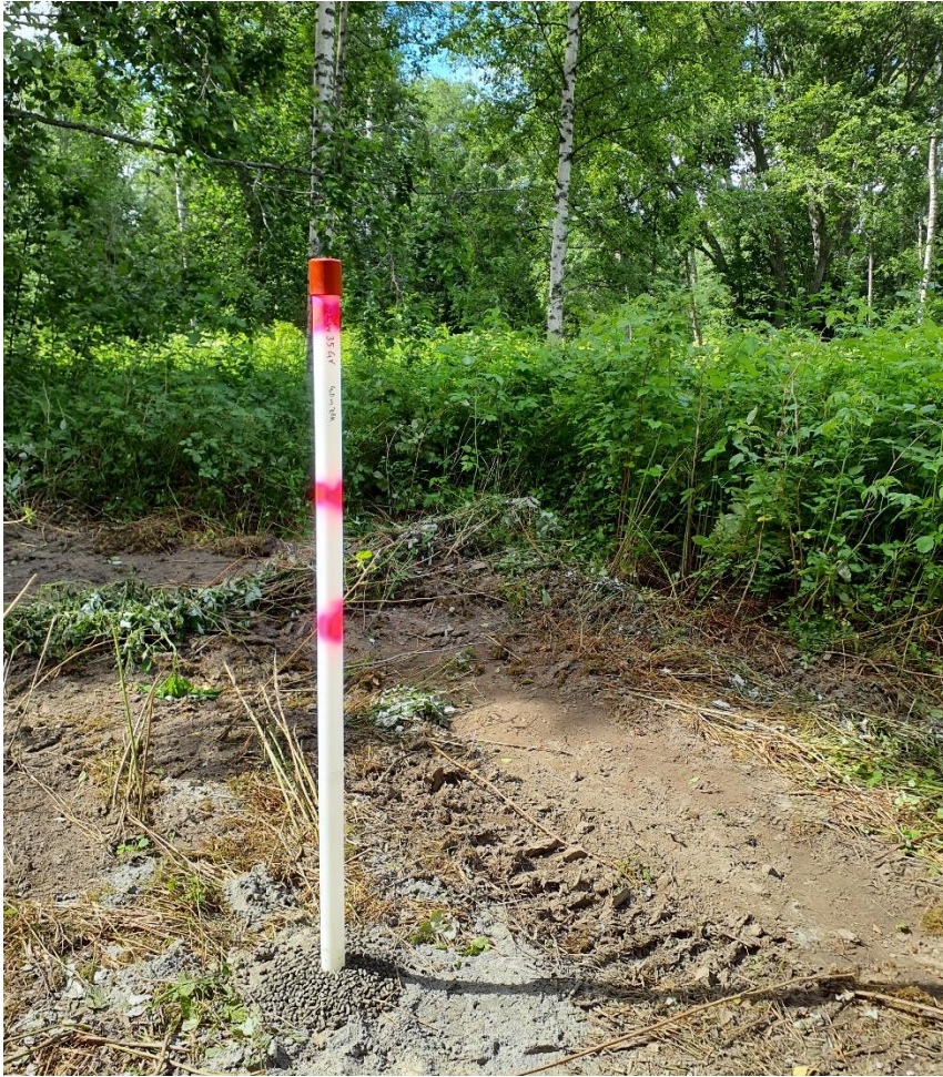
Figur 6. Installation av grundvattenrör 22W35GV.
