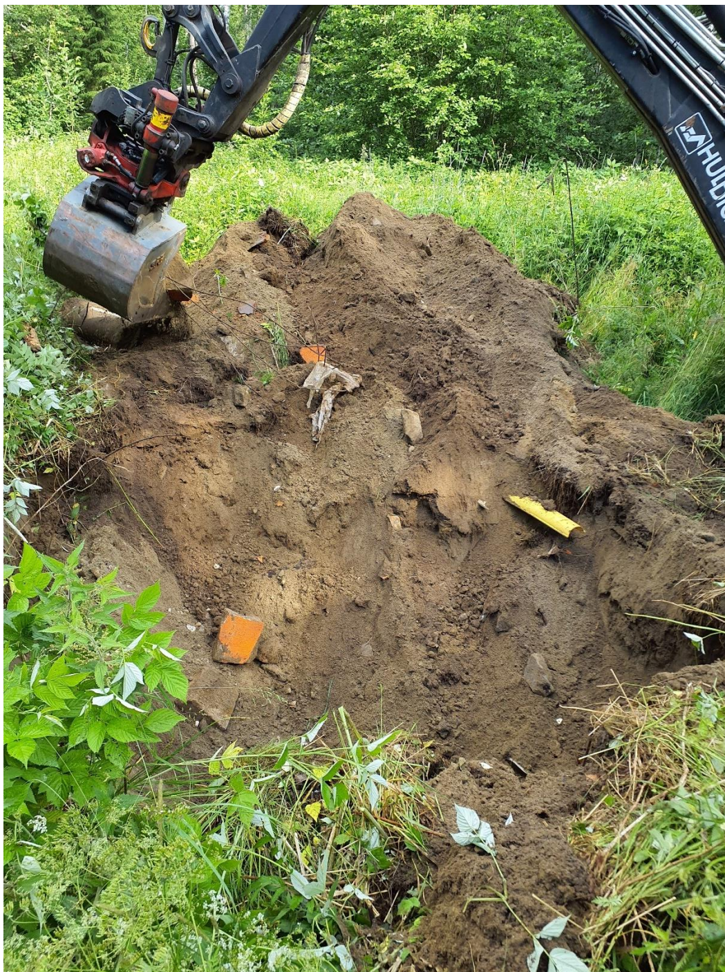
Bild 8a. Provpunkt 22W31. Provgrop innehållande bl.a. betongrör, betongbitar, tegel, armeringsjärn, plåtskrot, träplankor och plast.
