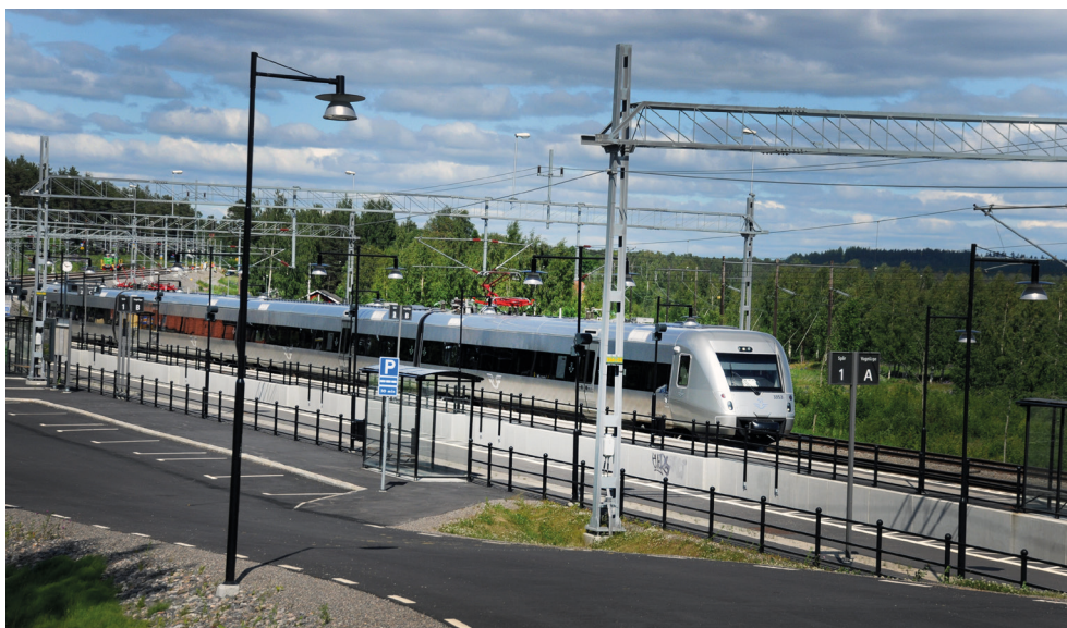
Det behövs en ny järnväg mellan Sundsvall och Härnösand.
