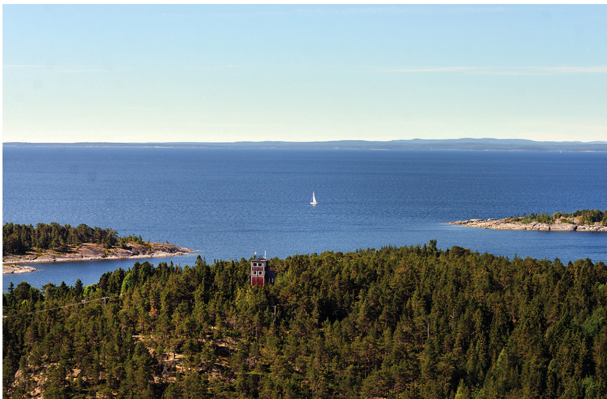
Flygfoto över del av Åstöns naturreservat där Lotstornet syns.
